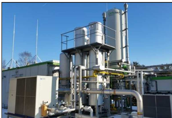
PSA adsorpcja zmiennociśnieniowa Fulda (Niemcy), płuczka wodna Cavaglia (Włochy) fot. proGEO
