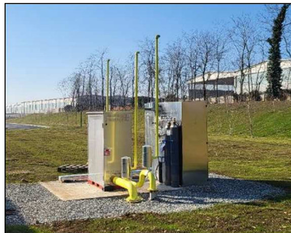
Instalacja załączania do sieci Strasbourg (Francja), Cavaglia (Włochy), fot. proGEO
